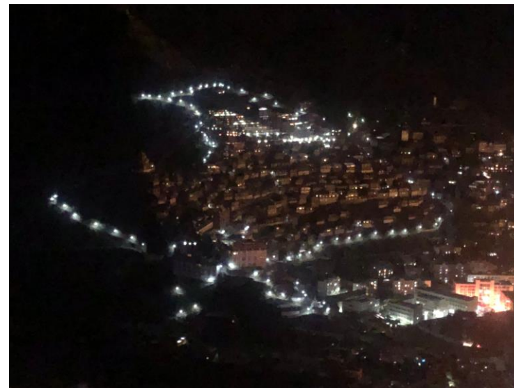
项目在西部村庄安装后的夜晚的亮起的路灯
